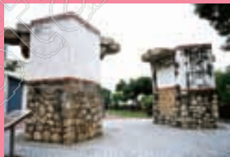
東福橋原支撐橋身的兩座橋墩。
