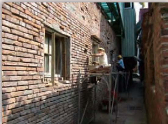
▲ 巷道外部分磚面敲除與抽換。
