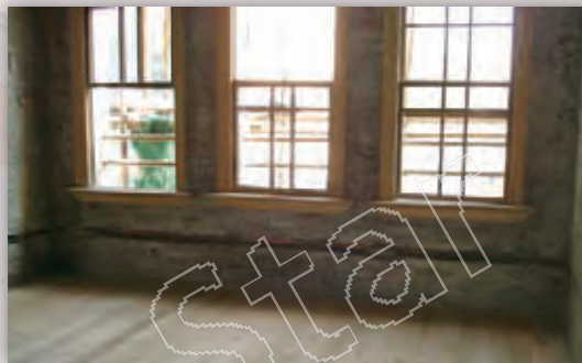
▲二樓近中山路木窗施作中。
