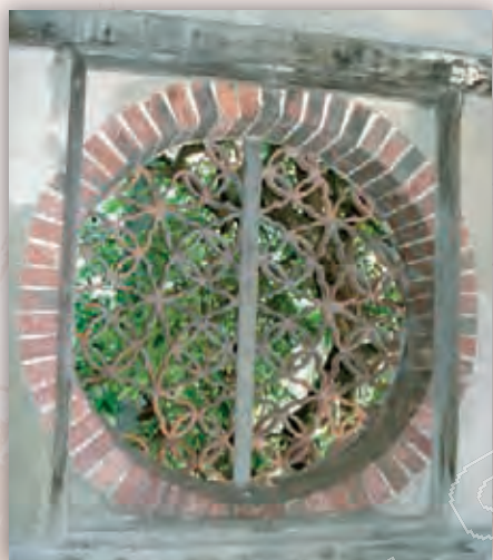
▲意樓圓窗修復前。
