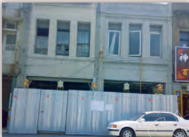
▲中山路121、123號正面修復前。
