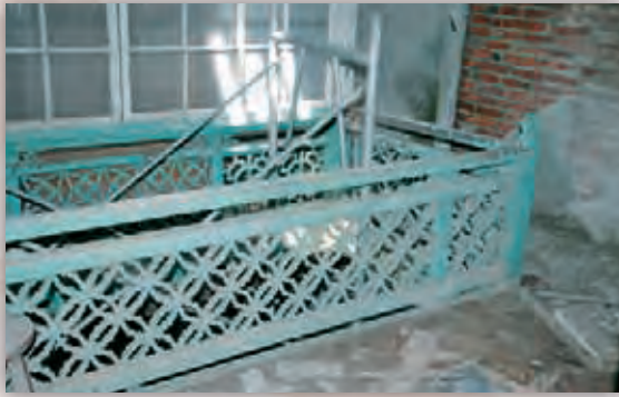
▲121號木樓井修復前。
