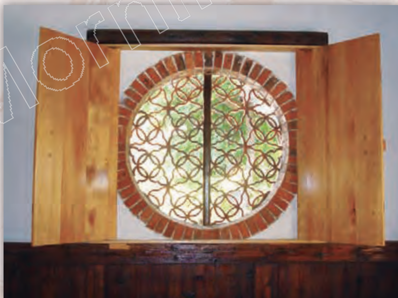
▲意樓圓窗修復後。
