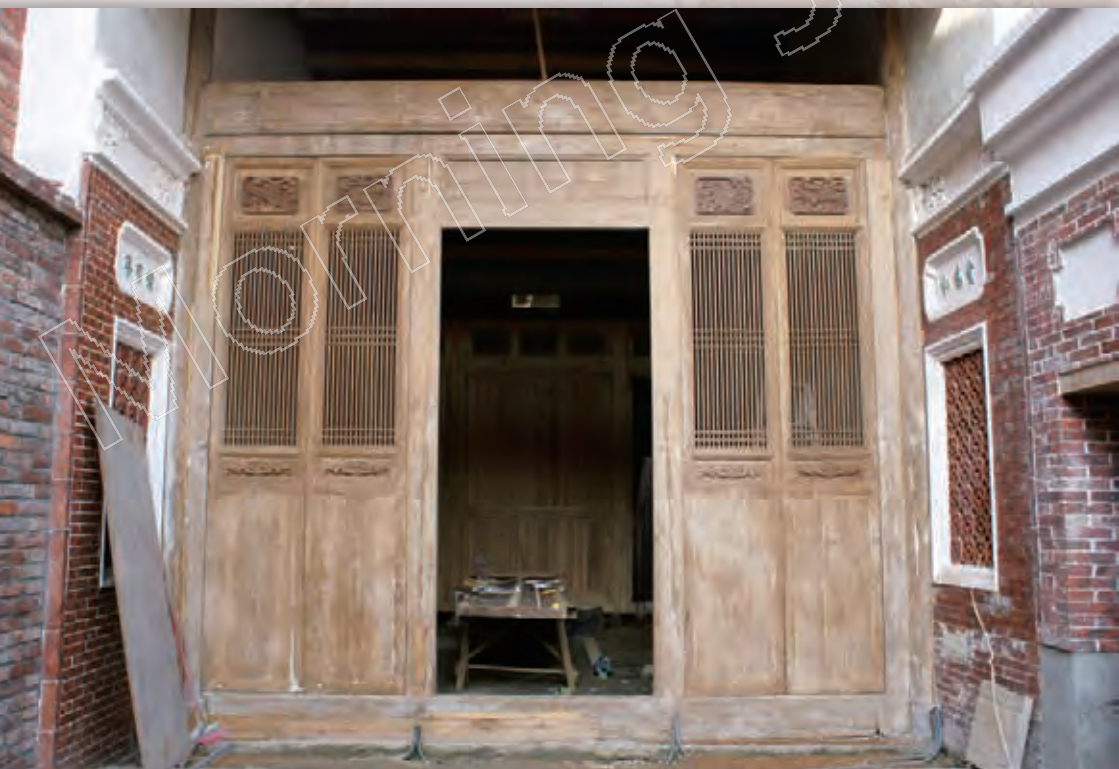
▲廳堂正面修復中。
