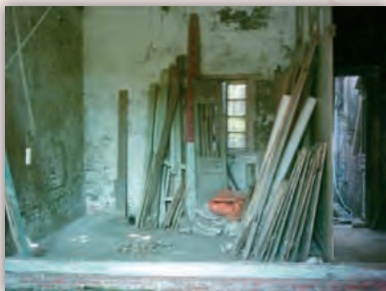
▲廳堂內木隔板修復前。
