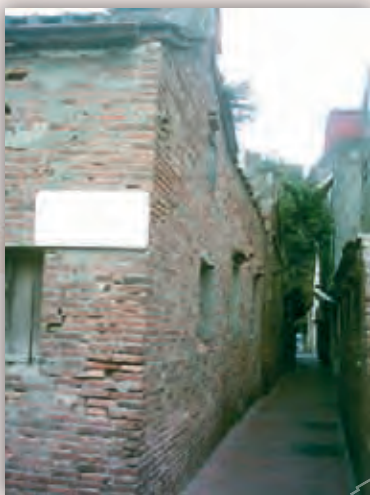
▲中山路121號右側面修復前。
