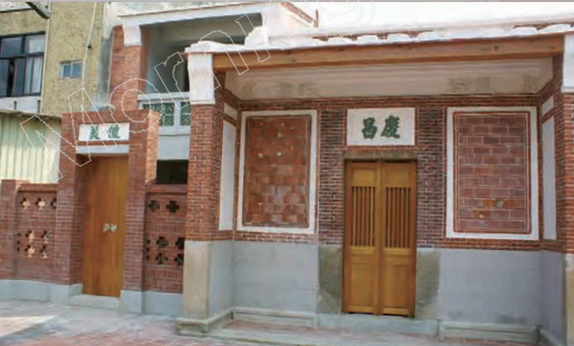
▲中山路121號「慶昌」、123號「俊美」修復完成後。
