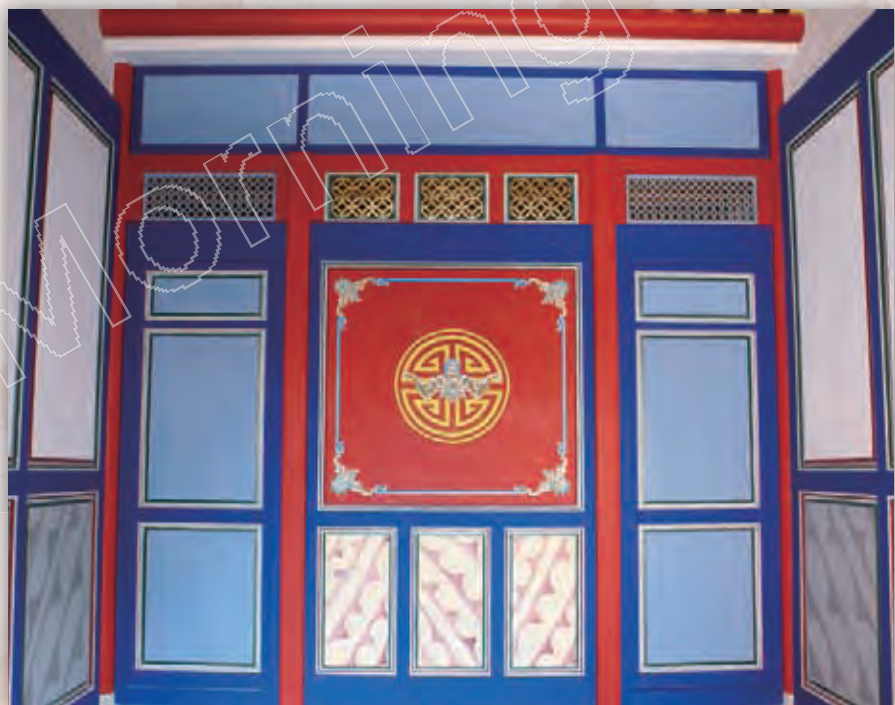
▲廳堂內木隔板修復後。
