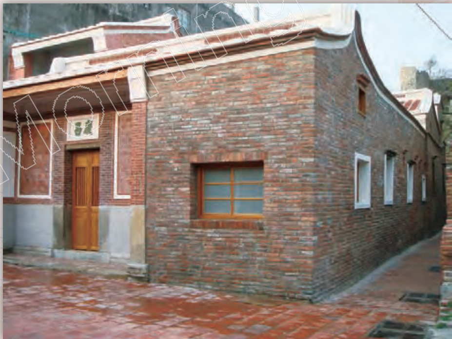
▲中山路121號右側面修復後。
