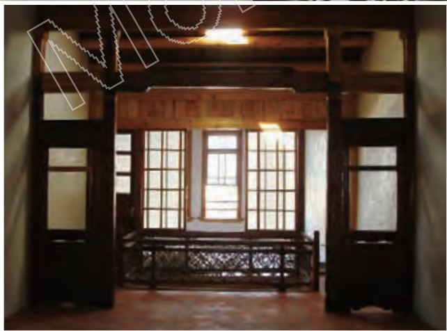
▲木隔扇及樓井修復後。
