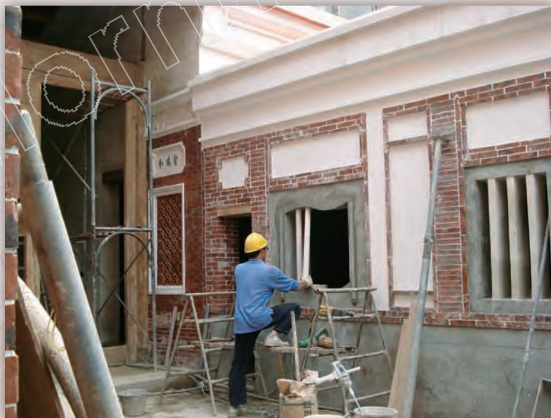
▲廳堂側邊牆面修復中。
