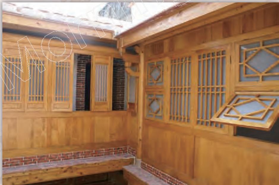
▲121號天井修復後。
