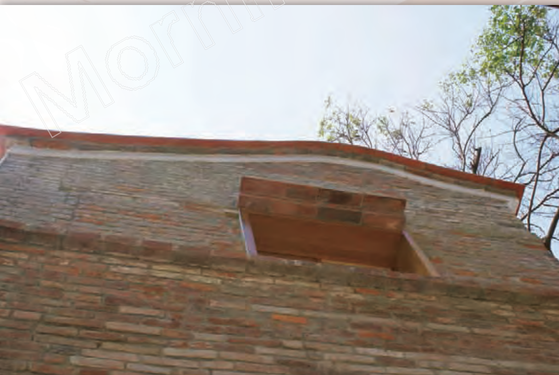
▼意樓側牆修復後。
