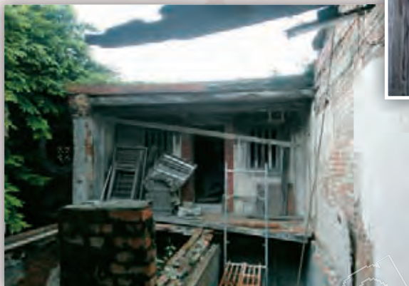
▲121號天井修復前。
