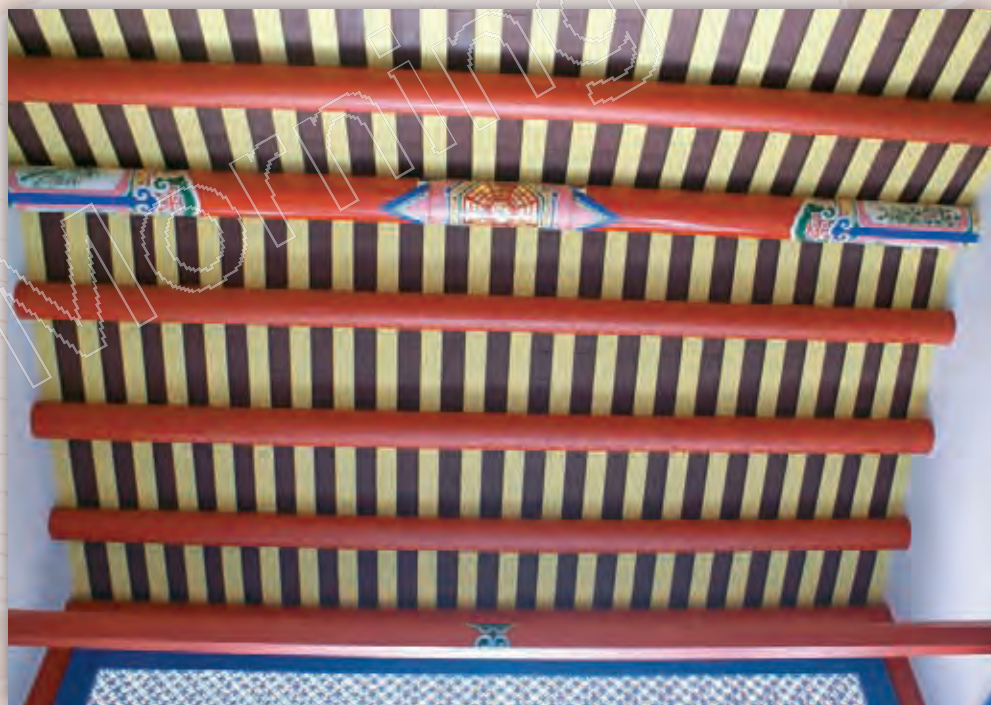
▲廳堂屋桁修復後。
