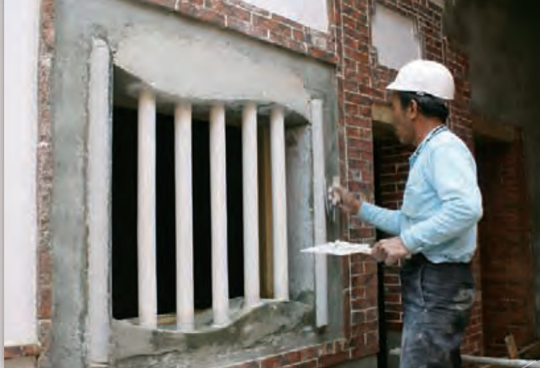
▲廳堂側邊書捲窗修補中。
