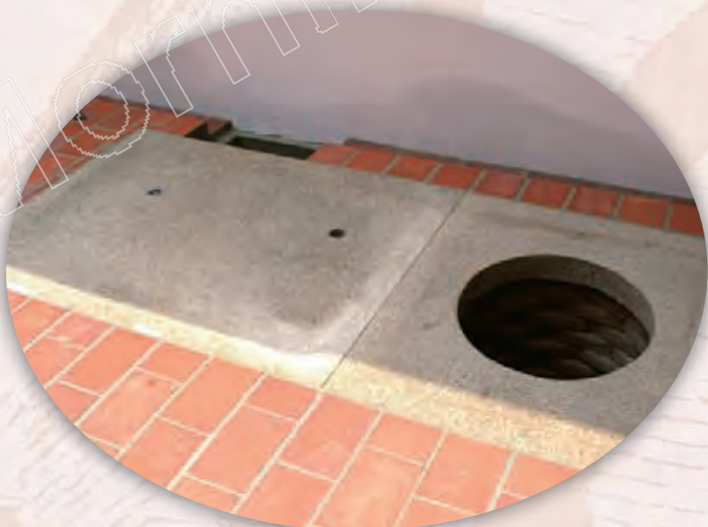
▲庭園舊有水井口修復後。
