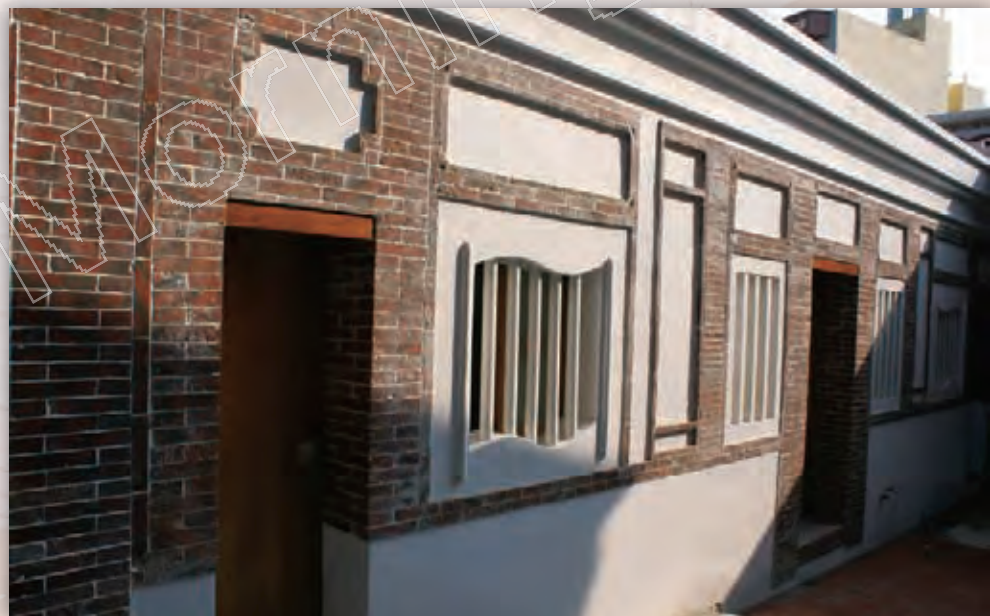
▲庭園側邊牆面修復後。
